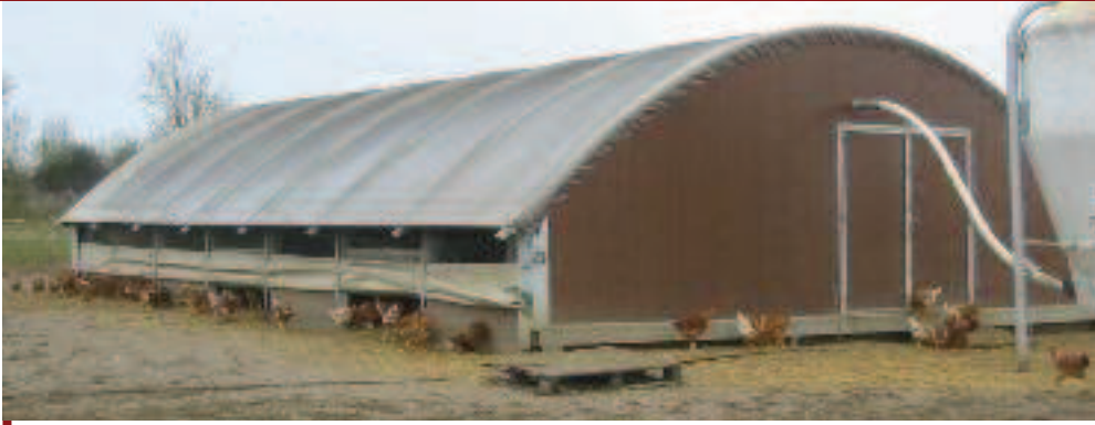
L'emplacement des bâtiments est choisi en fonction du sens du vent (Sud-Ouest) et de l'ensoleillement.
